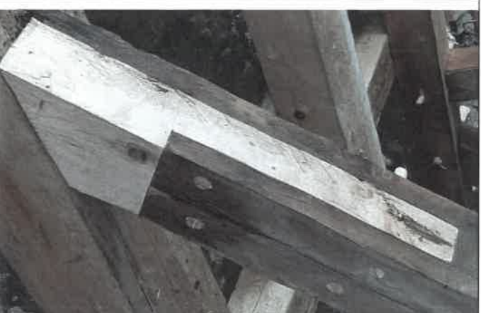
Eksempel på reparasjon av taksperre, med innfelling av ny sperrefot.
