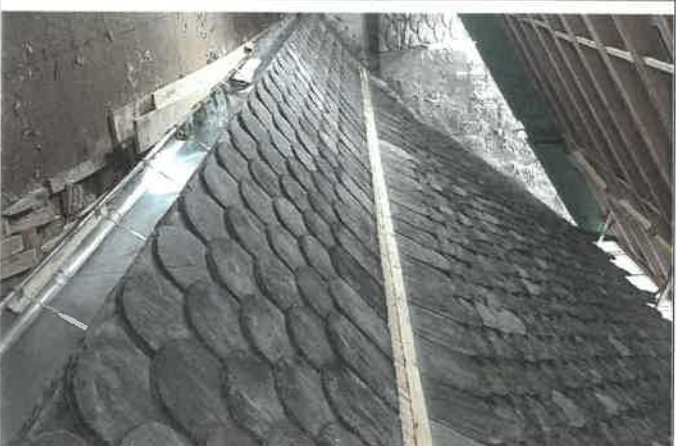
Skiferlegging godt i gang, svaktaket er her tilbakelagt. All stein er i tillegg bært opp og fordeelt og forberedt for legging.
