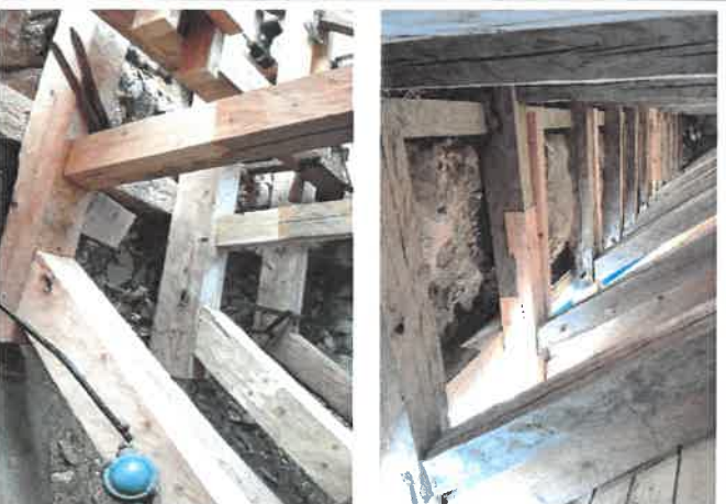
Det er utført reparasjon, utskifting og etablering av nye sammenføyninger for både murremmer, loftsbjelker, taksperrer og gesimsustikk.
