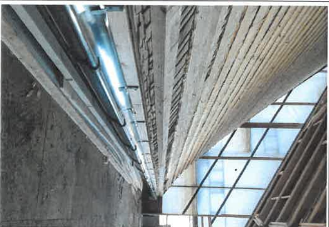
Ferdig reparert og opplekket tak, med takrenner av ren sink - klart for legging av skifer.
